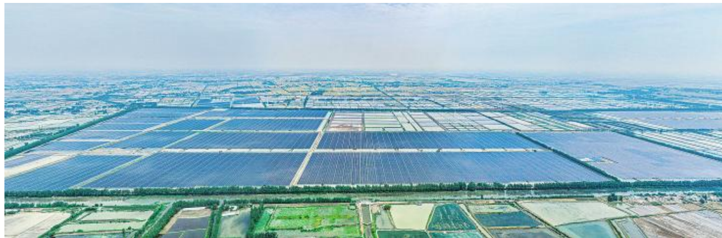
通威天门“渔光一体”项目
