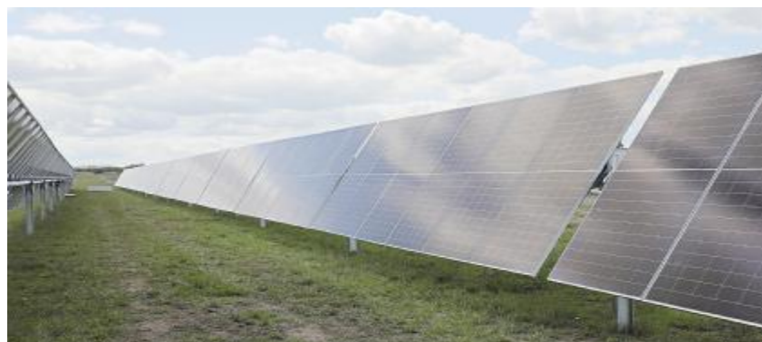
应用通威高效组件的澳洲光伏项目
