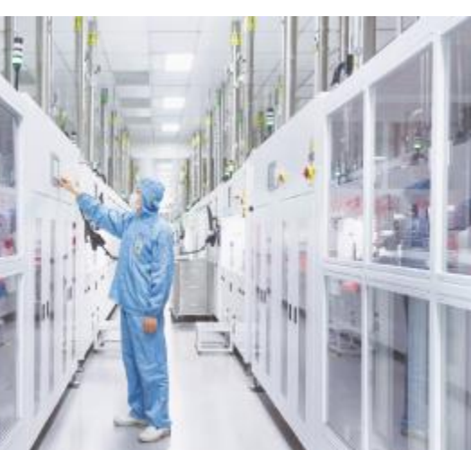
吴聪聪对设备运行参数进行针对性调试
